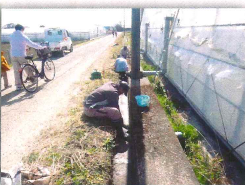
2025,3,7 水路簡易補修
